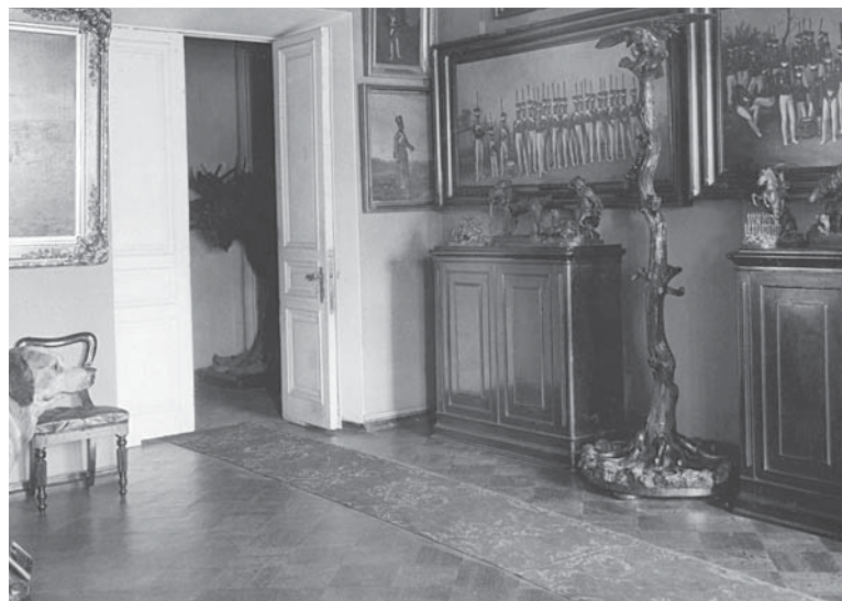
3. Приемная императора Александра II в Гатчинском дворце. Фото А. М. Величко. 1930-е
